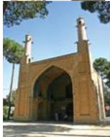
Shaking minaret (Menar Jonban)
